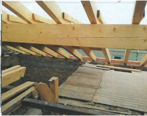
Große Schäden im Dachstuhl aufgrund von eindringender Feuchtigkeit zwangen uns dazu, diesen komplett zu erneuern.
